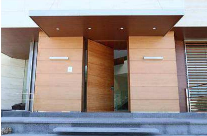
reemplazada sin problemas si fuese necesario. Además proporciona un confortable aislamiento del exterior debido a que incorpora dos burletes acústicos escamoteables en la parte inferior y superior de la hoja, así como dos juntas perimetrales de estanqueidad.
